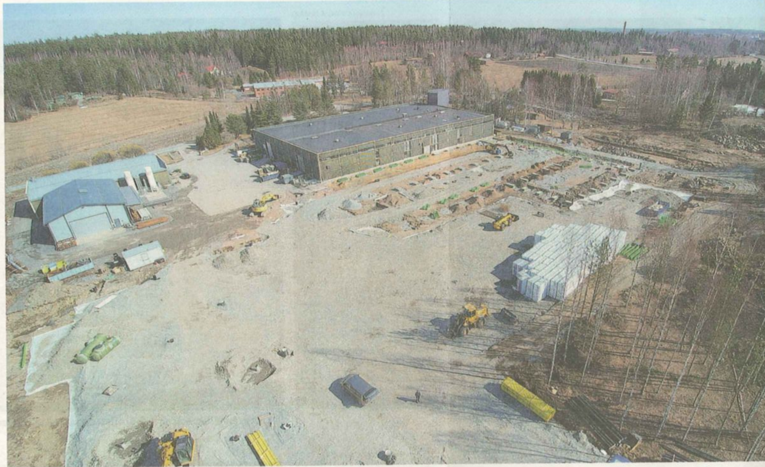
Lojerin Sastamalan-tehtaan laajennuksen rakentaminen on parhaillaan käynnissä.
