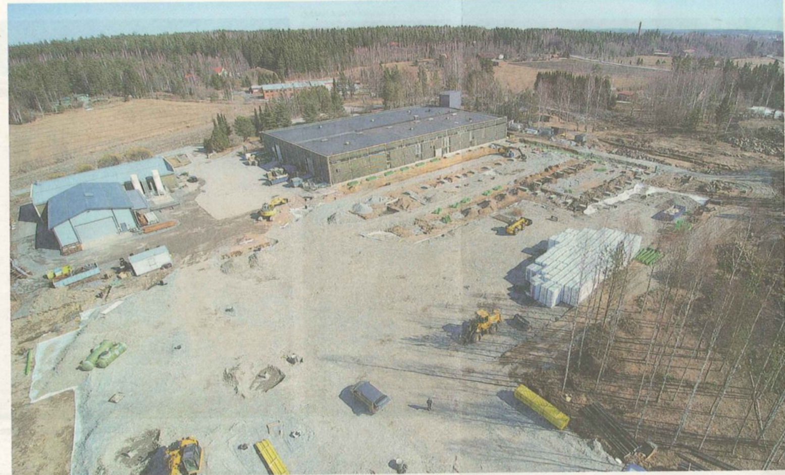
Lojerin Sastamalan-tehtaan laajennuksen rakentaminen on parhaillaan käynnissä.
